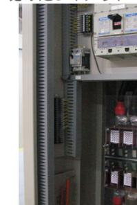
※高速電源切替装置は、冗長システムを構成した2系統（常用系UPS、予備系UPS）の電源を瞬断時間5ms以下で切替る装置です。
